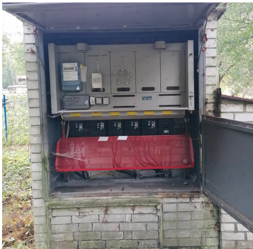
Obr. Elektroměrový pilíř s rozváděčem RE s elektroměrem, hl. distribučním jističem (vlevo) a s jističi vývodů pro areál
