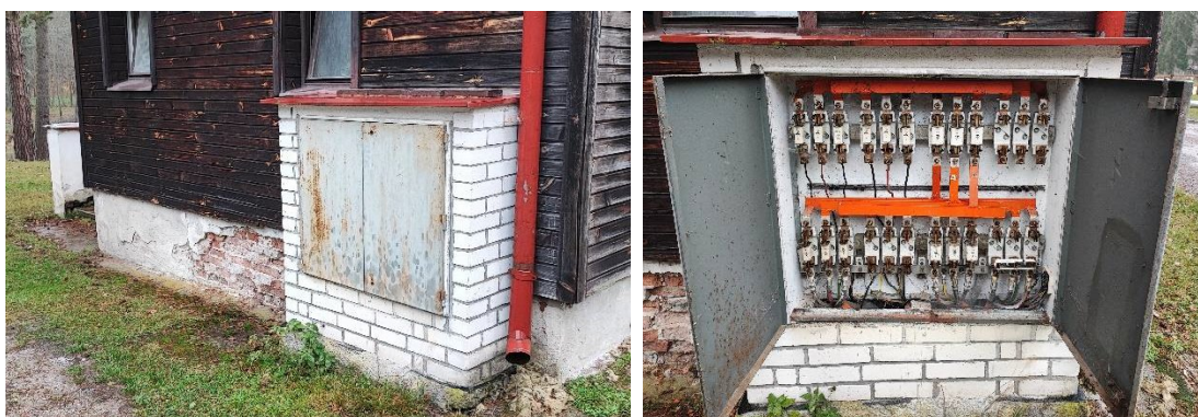
Obr. Příklad pojistkové skříně RIS u objektu č. 8
