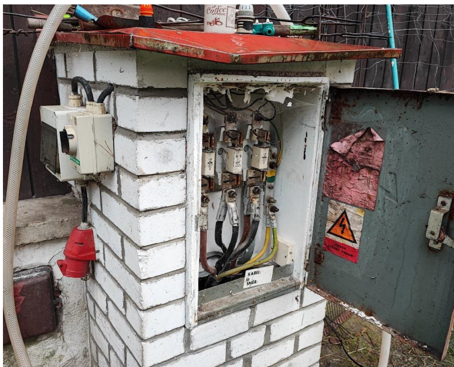
Obr. Příklad přípojného místa u jednotlivých objektů
